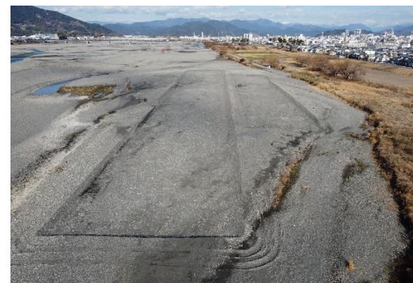
写真: 河道掘削(0.2k付近) 中島地区
