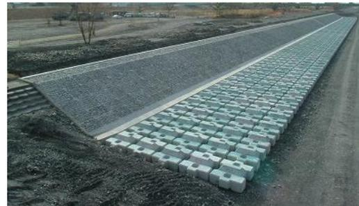
**巨石付き盛土砂州**：目指すみお筋となるよう、砂州頂部を巨石により防護した盛土を設置し、主流を滑らかに河道中央に誘導する対策工
