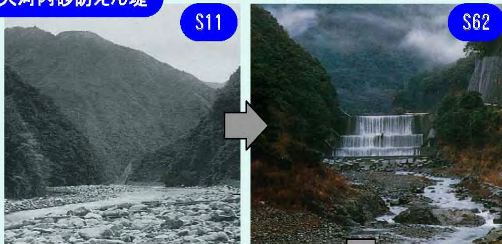
大河内砂防えん堤
