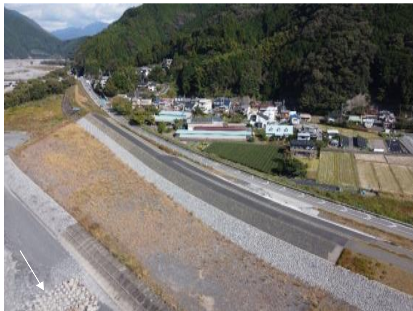
写真: 堤防整備後(左岸21.75km付近) 俵沢地区
