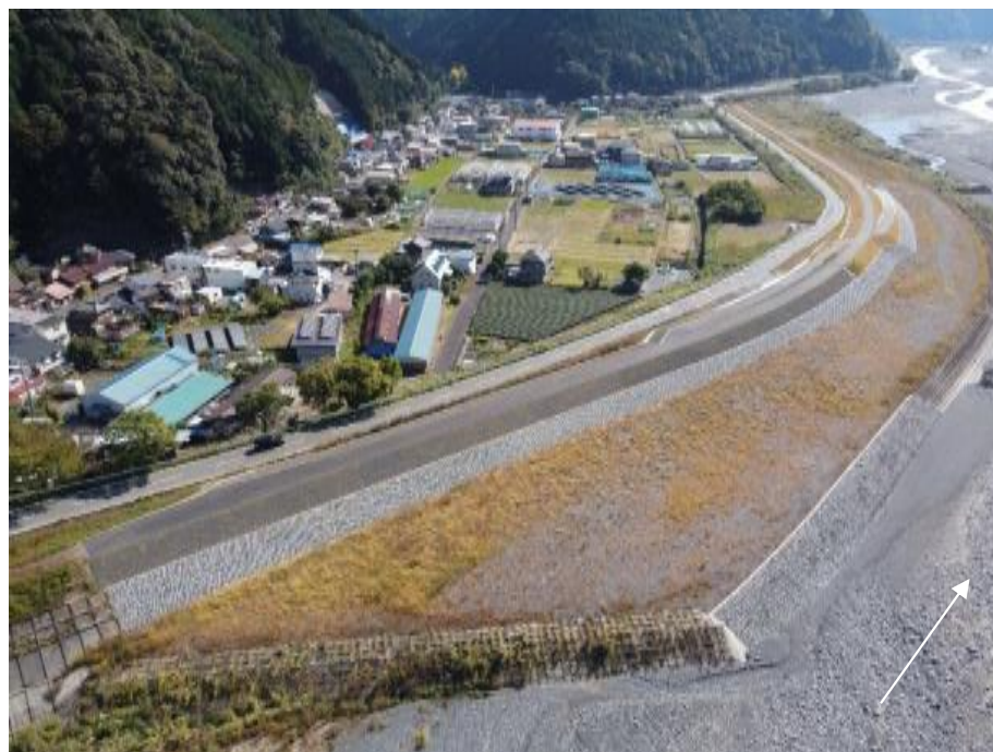
写真:堤防整備後(左岸21.75k付近) 俵沢地区
