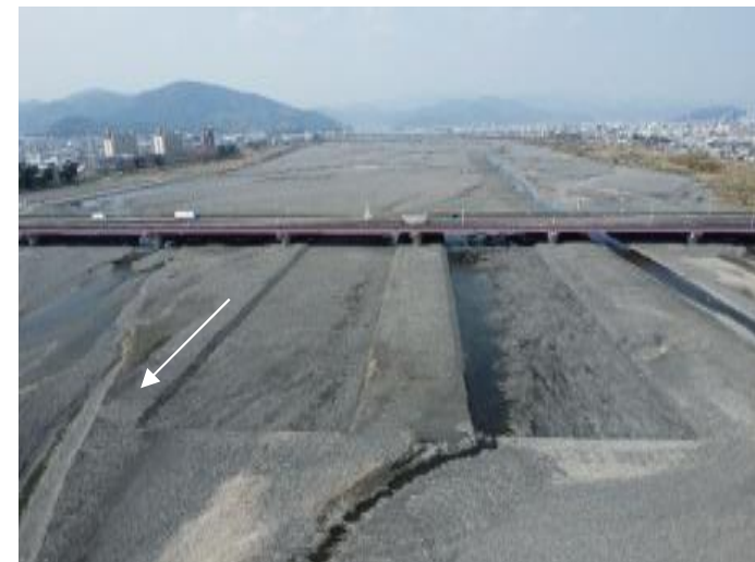
写真：河道掘削(1.50k付近) 中島、下川原地区
