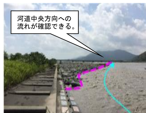
安倍川左岸 8 k (試験施工)
