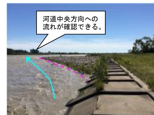
安倍川右岸 8.5 k (試験施工)
