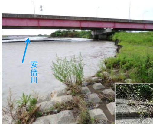
令和2年7月豪雨 ▶ 牧ヶ谷地先護岸損傷状況 (藁科川右岸0.5k)
