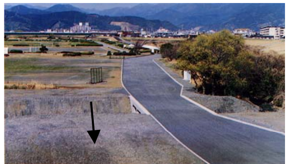
緊急用河川敷道路 (安倍川6.5k付近左岸)
