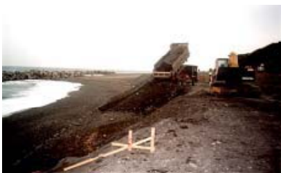
海岸への養浜土砂投入状況 (安倍川から運搬した土砂を投入)
