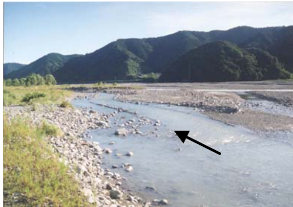
取水のため河道内に水路を掘り 導水している状況
