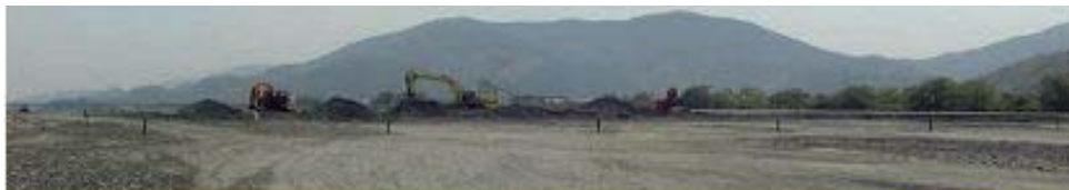
安倍川での緊急河道掘削状況
