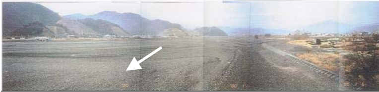
狩野橋上流の水枯れ状況
