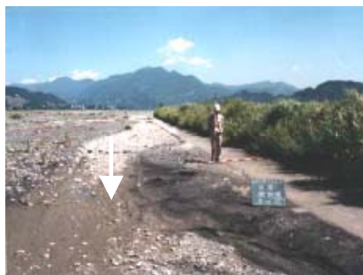
河床上昇状況 （安倍川 9.5k 付近左岸）
