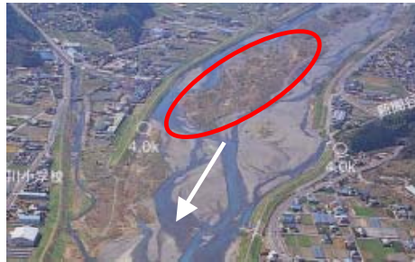
河道内樹木の繁茂状況 (藁科川 4k~5k 付近)
