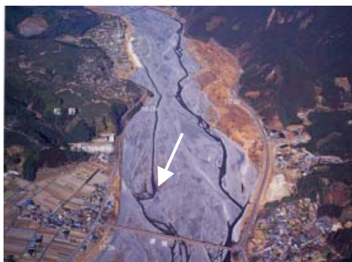
中流部の河川景観 (安倍川 17k ~ 18k 付近)
