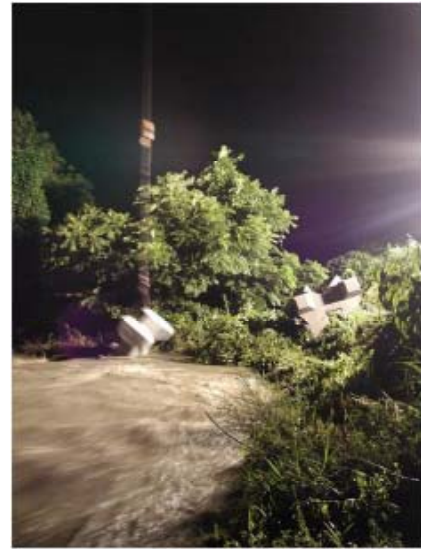
平成 14 年 7 月災害 慈悲尾地先 応急復旧作業状況 （安倍川 8.25k 付近右岸）
