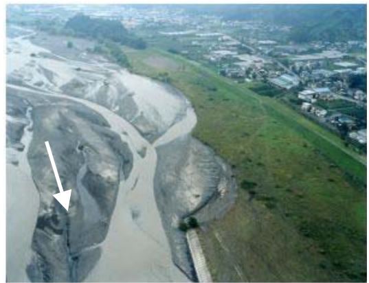
平成 12 年 9 月災害 450m 程度の河岸侵食 (安倍川 12.0k 付近左岸：福田ヶ谷地先)
