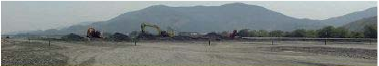
安倍川での緊急河道掘削状況 （掘削土砂の一部を海岸への養浜に利用している。）
