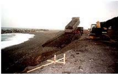
海岸への養浜土砂投入状況 （安倍川から運搬した土砂を投入）
