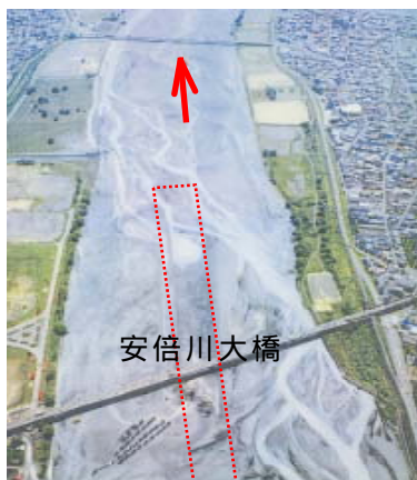
緊急河道掘削 (安倍川 7.0k 付近)
