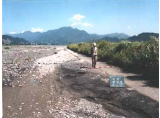
河床上昇状況 (安倍川 9.5k 付近左岸)
