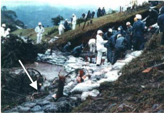
昭和 57 年 8 月災害 蛇籠・土嚢による応急工事 (12.0k 付近左岸：福田ヶ谷地先)
