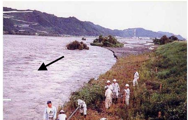
平成 12 年 9 月災害 近年は越水、破堤の被害は生じていないが、堤防及び護岸が侵食される被害が発生している。
