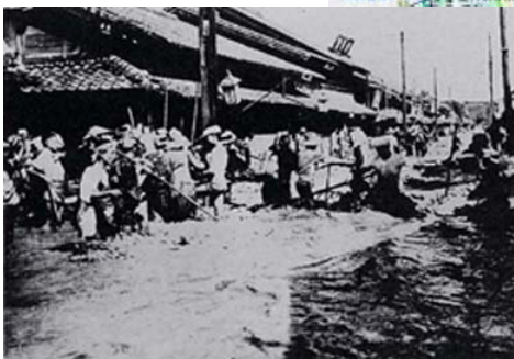
大正3年8月洪水による 静岡市柳町の被害状況
