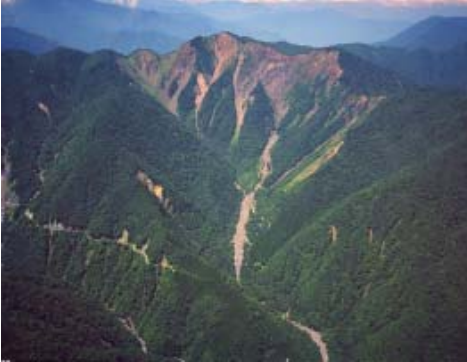
安倍川上流部 (大谷崩 おおやくずれ ) 日本三大崩れの一つであり、下流部へ土砂を供給している。
