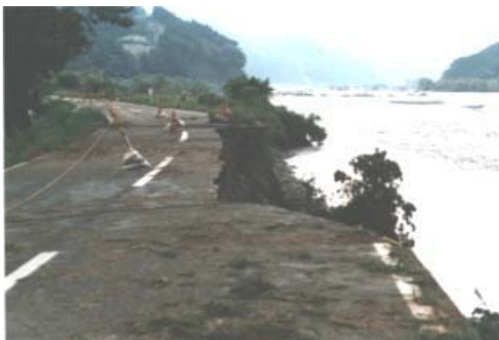
平成 3 年 9 月災害 俵沢地区 (安倍川 21.5k 付近左岸)
