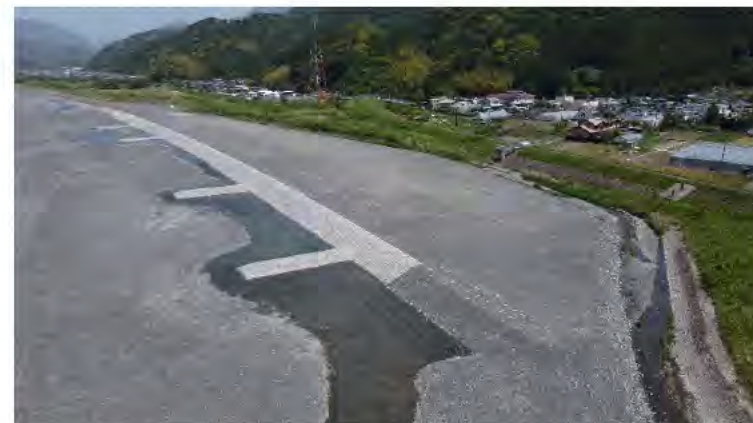
R2安倍川藁科川築堤護岸工事(13.50k付近)
