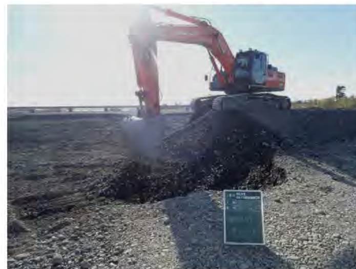
R2安倍川下流部河道掘削工事(2.00k付近)
