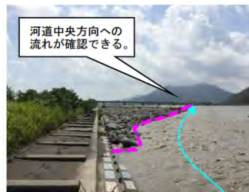
安倍川左岸 8 k (試験施工)
