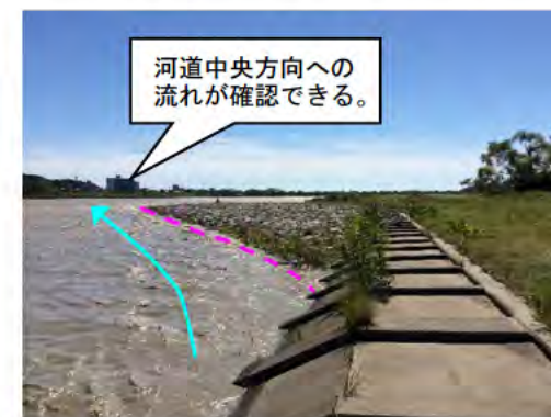
安倍川右岸 8.5 k (試験施工)
