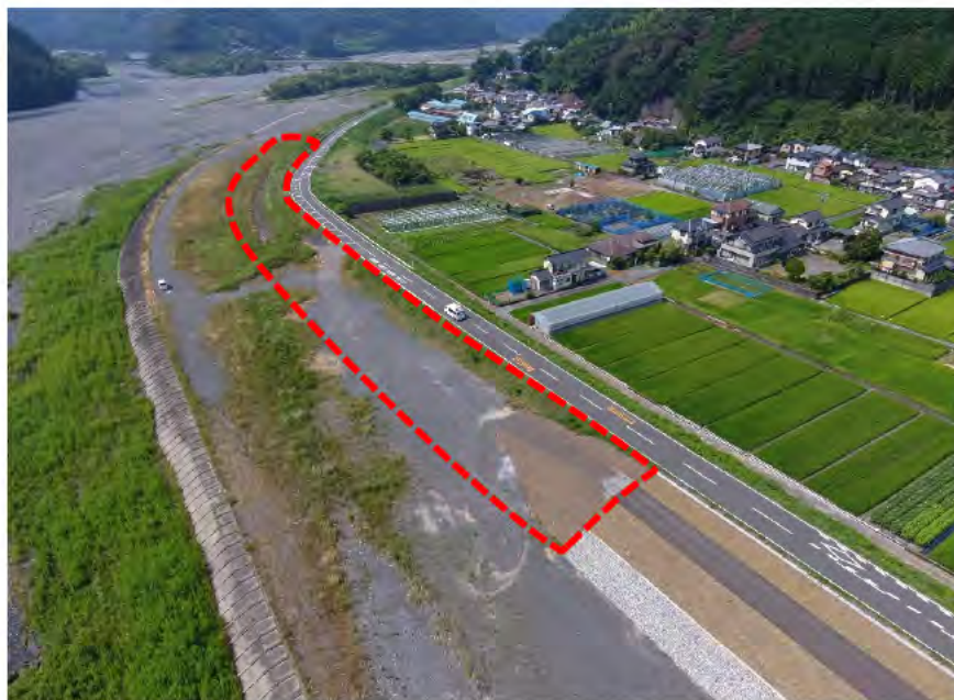
R2安倍川俵沢周辺堤防整備工事 整備前(21.50k左岸付近)
