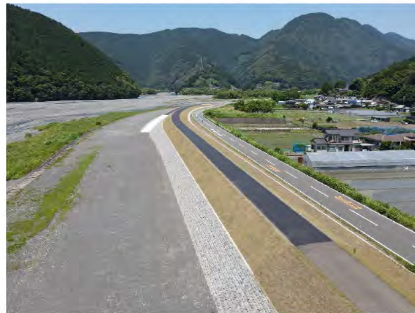
R2安倍川俵沢周辺堤防整備工事 整備後(21.50k左岸付近)
