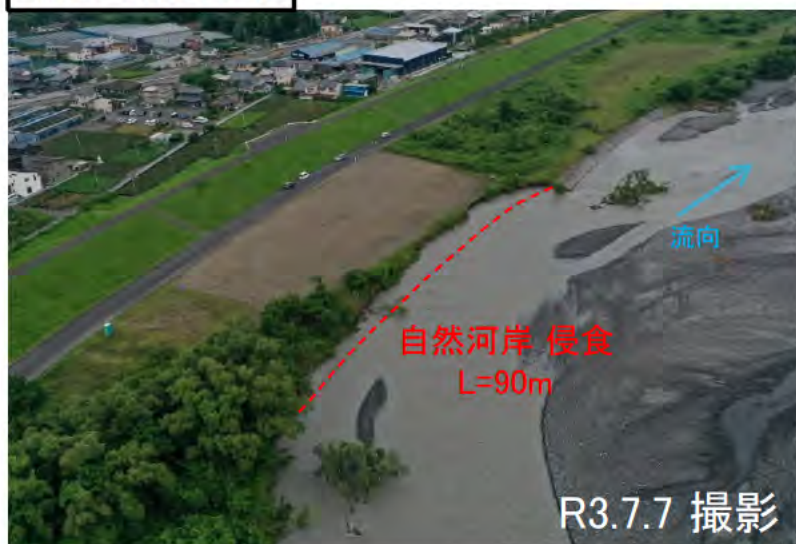
被災箇所発見時
