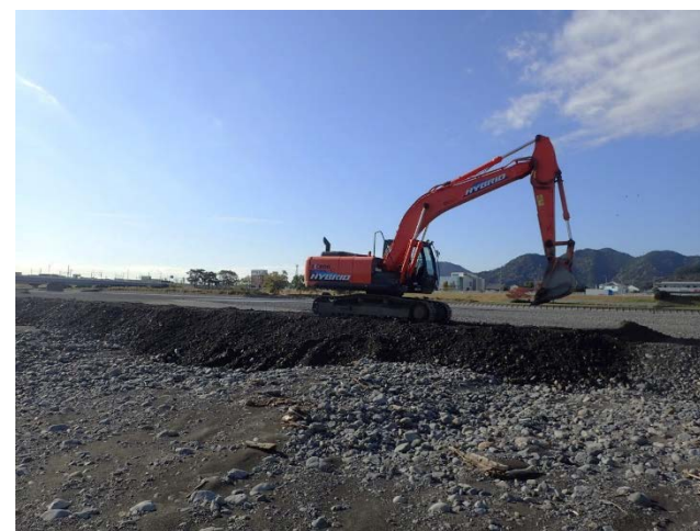
R1 安倍川手越河道掘削工事(3.75k付近)
