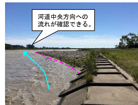
安倍川右岸 8.5 k (試験施工)
