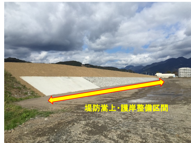
H31 安倍川安倍口築堤護岸工事(10.50k付近)
