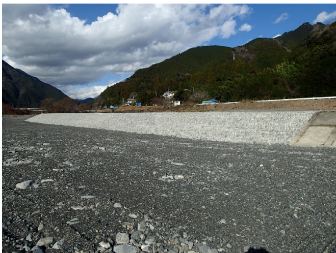
R1安倍川俵沢周辺堤防整備工事 (21.75k左岸付近)
