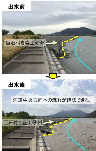
図-6 左岸8k 定点写真比較 (台風21号)
