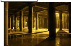
大規模地下貯留施設
