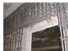
処理場の耐震化 (躯体補強)
