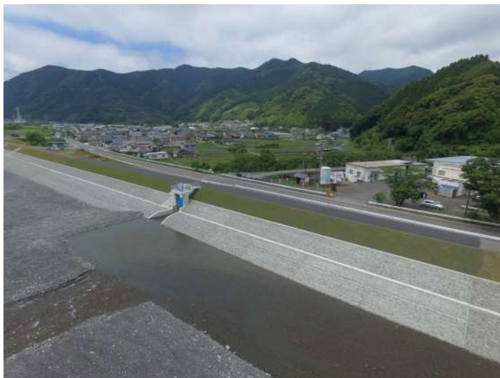
H27油山樋管及び築堤護岸工事 (17.50k右岸付近)
