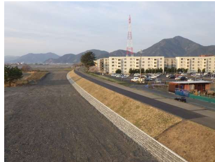
H29安倍川安倍口築堤工事 (10.00k右岸付近)
