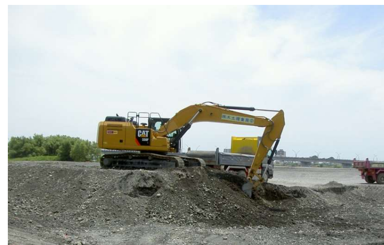
H29安倍川手越河道掘削工事(3.00k付近)
