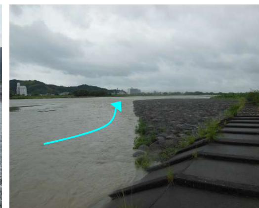
安倍川右岸 8.5 k (試験施工)
