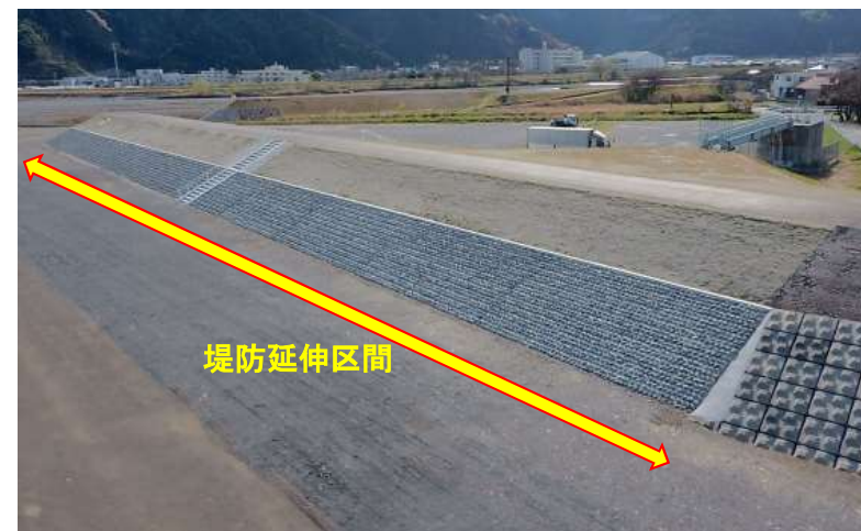
H27山崎地区築堤工事(5.75k右岸付近)
