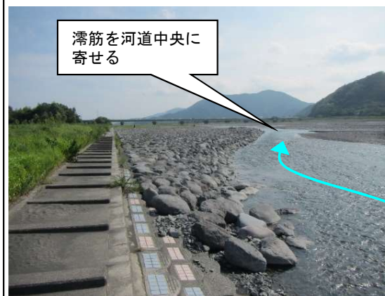
安倍川左岸 8 k (試験施工)
