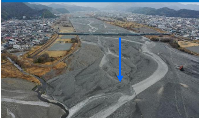
瀬切れ: 狩野橋上流(令和8年2月24日)
