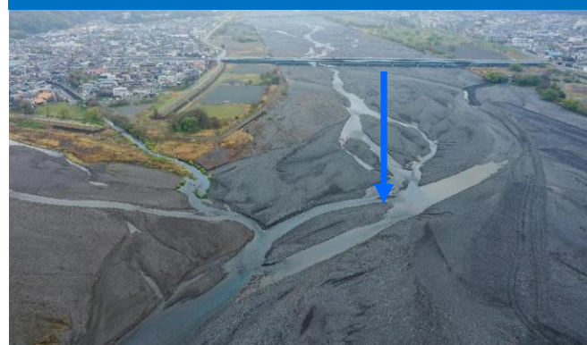
瀬切れ解消: 安西橋下流(令和8年3月30日)
