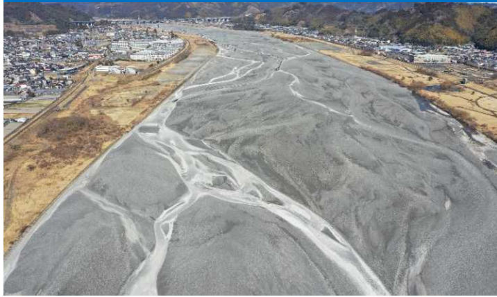
①起点：狩野橋上流（令和7年2月25日現在）
