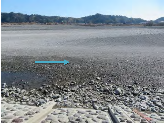
①安倍川:狩野橋上流側↑
