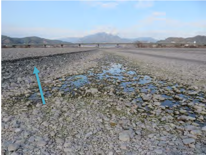
①安倍川: 狩野橋下流側↑
