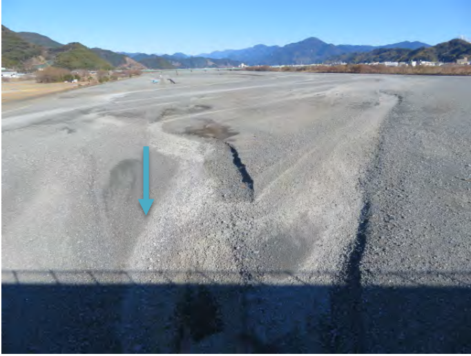
① 安倍川安西橋上流側↑
