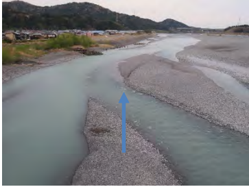
大井川用水水路橋下流側(21.0km付近)(3月28日)
