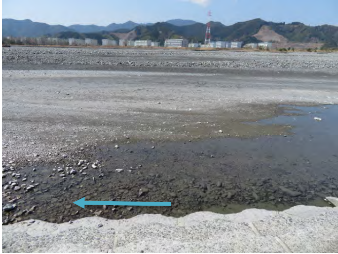
①安倍川狩野橋上流側↑
