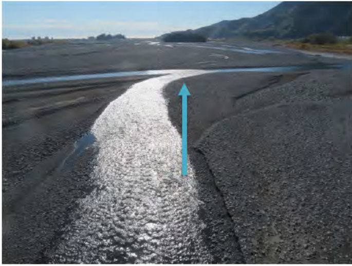
① 安倍川安西橋下流側↑ (令和3年12月17日の様子)
