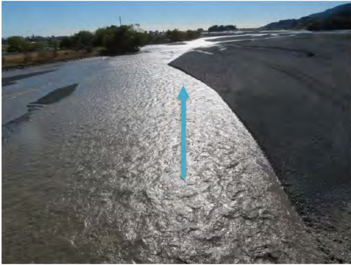
①安倍川安西橋下流側↑ (令和3年12月1日の様子)
