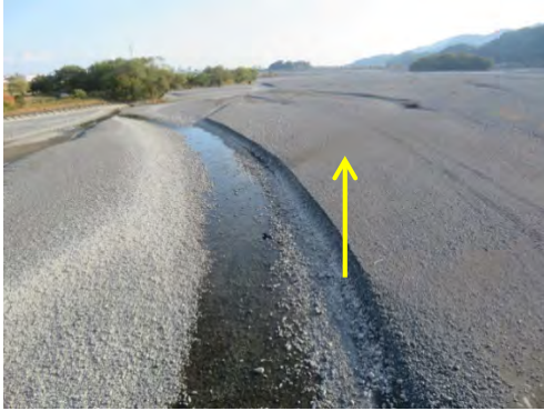
①国道362号 安西橋付近 (5.9km) 令和3年11月17日の様子
