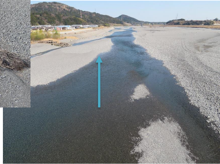
同橋下流側の滞筋部
