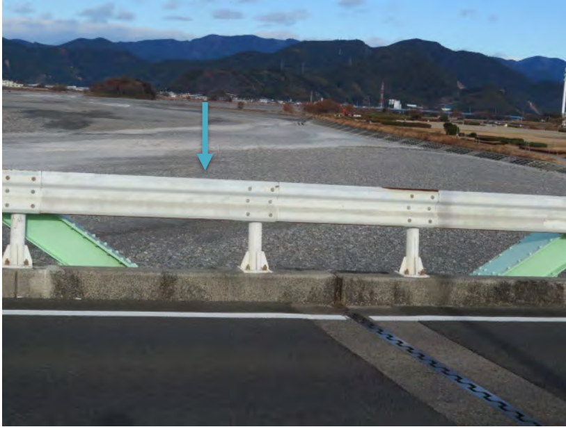
③安倍川 4.5kp付近 安倍川橋(弥勒橋)上流側
