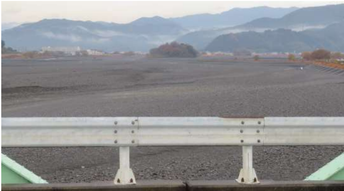
③安倍川 4.5kp付近 安倍川橋(弥勒橋)上流側
