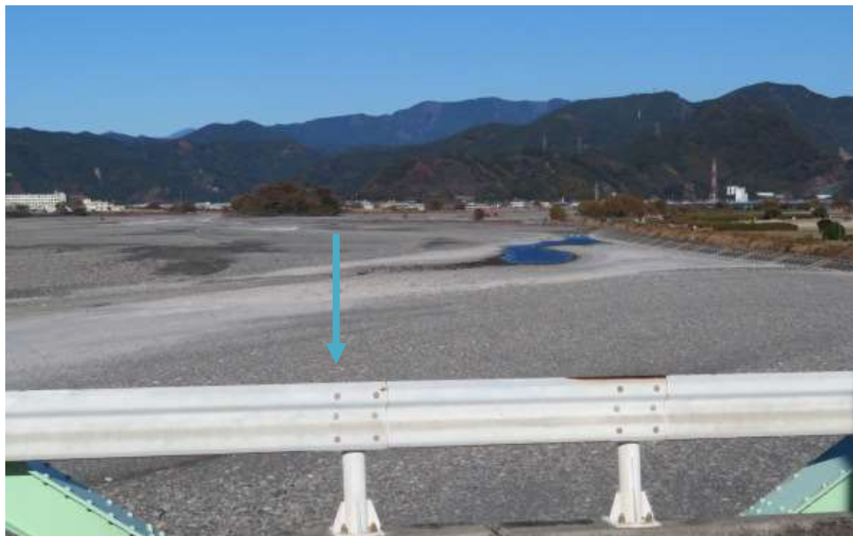
③安倍川 4.25kp付近 安倍川橋(弥勒橋)上流側
