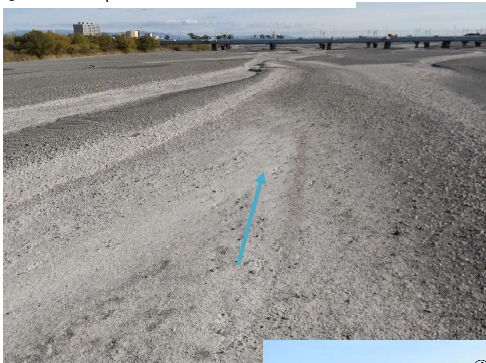
③安倍川 4.0kp付近 安倍川橋(弥勒橋)下流側
