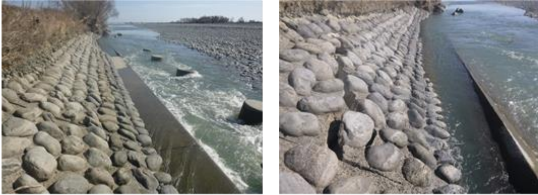
図 2-1 偏流による低水護岸の損傷
