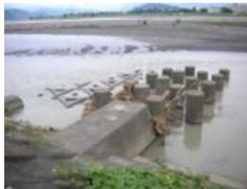
図 2-8 コンクリートポスト水制
