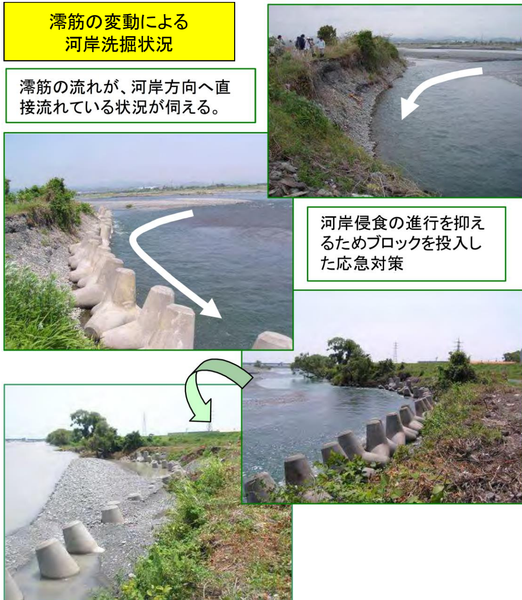
図 2-2 滞筋の変動による河岸洗掘状況
