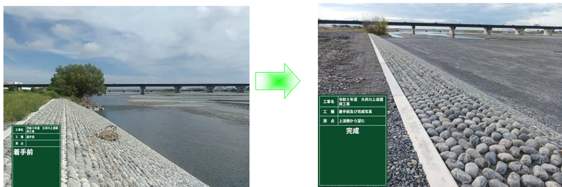
図-21 低水護岸整備施工状況
