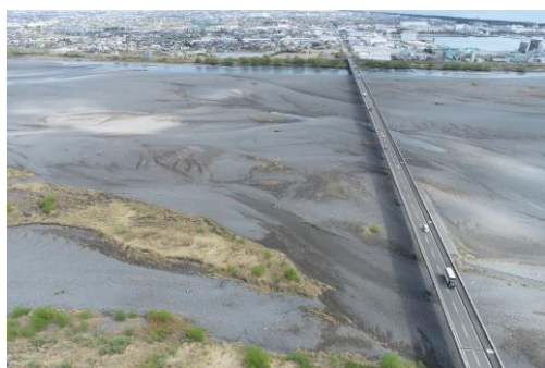
河道掘削施工前
