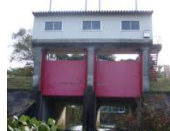
横岡排水樋管
