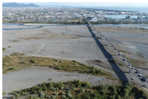
河道掘削施工後
