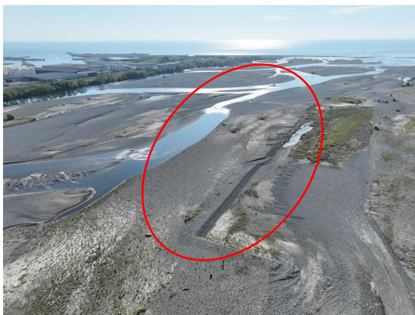
河道掘削施工前
