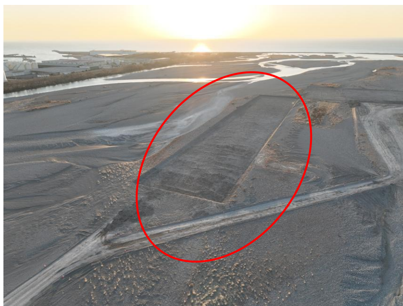
河道掘削施工後
