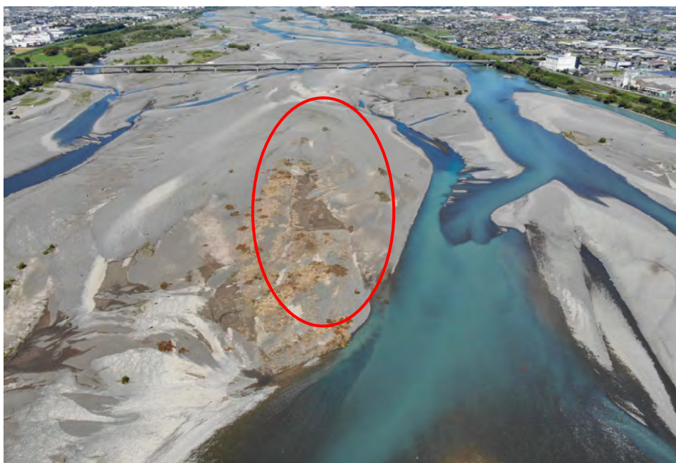
河道掘削施工前
