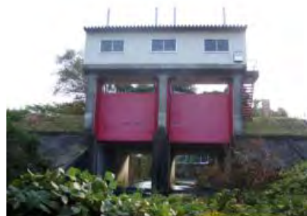
横岡排水樋管
