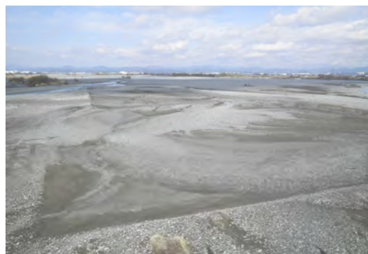
河道掘削施工後
