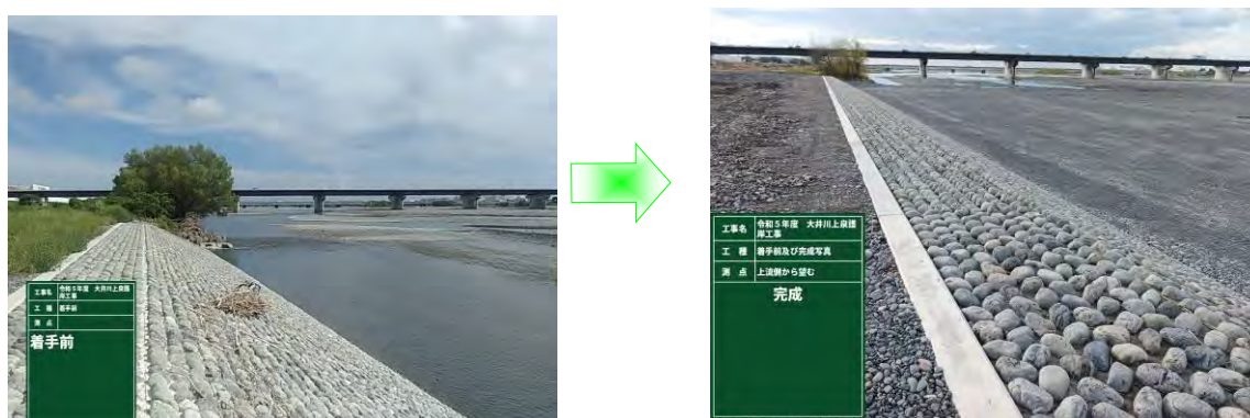
図-21 低水護岸整備施工状況
