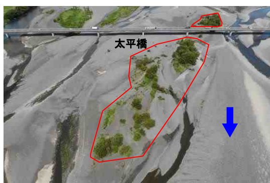
河道掘削施工前
