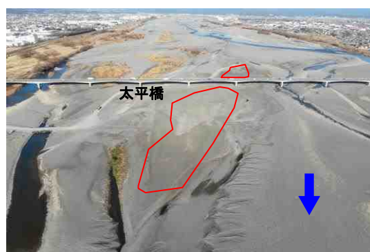
河道掘削施工後
