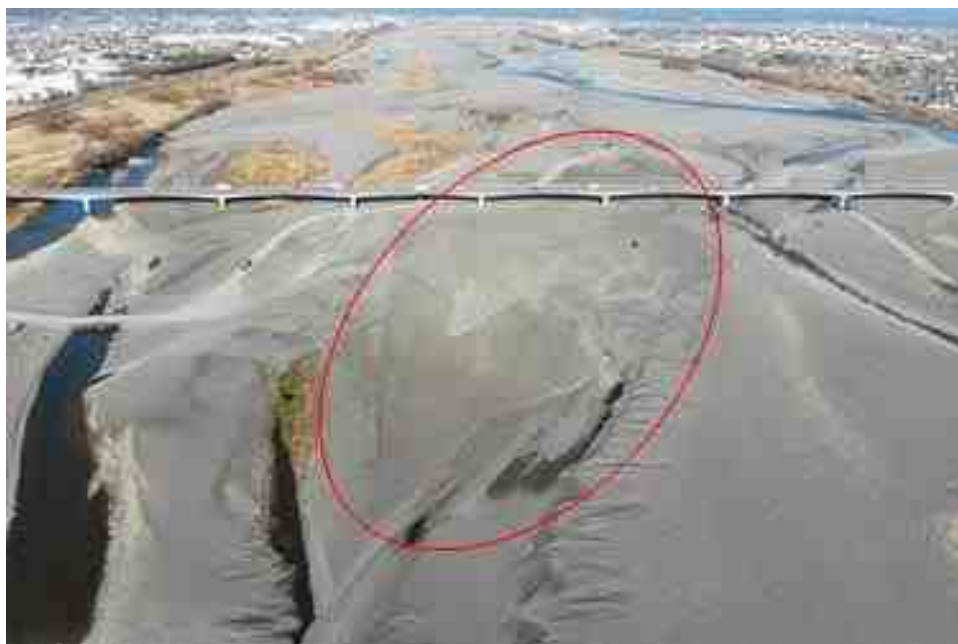
河道掘削施工後
