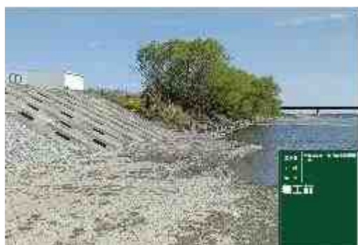
図-21 低水護岸整備施工状況
