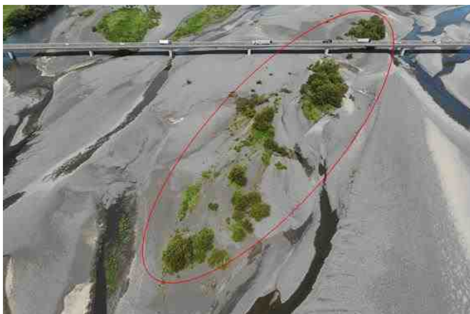
河道掘削施工前
