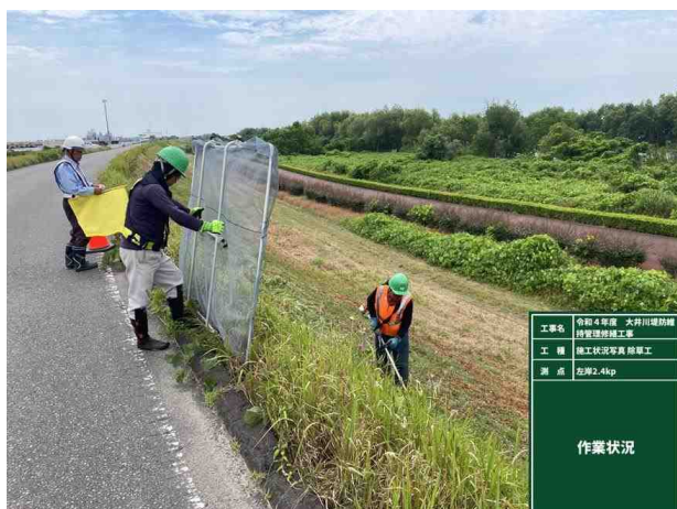
図－7 除草実施状況
