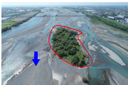
河道掘削施工前
