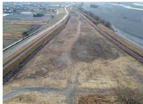
図-11 左記処理後の状況
