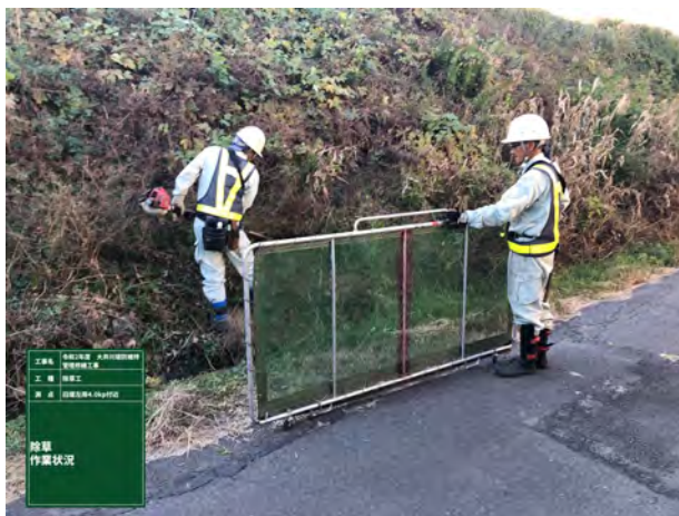
図-7 除草実施状況
