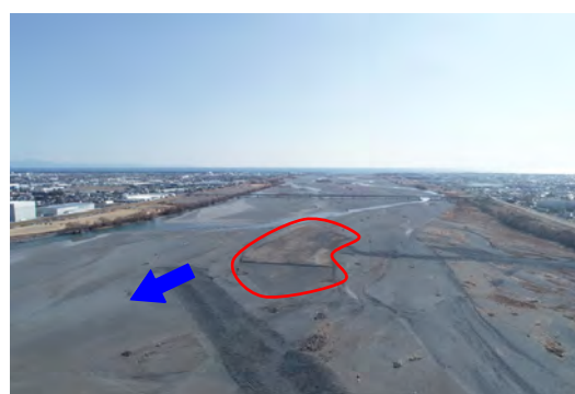
河道掘削施工後
