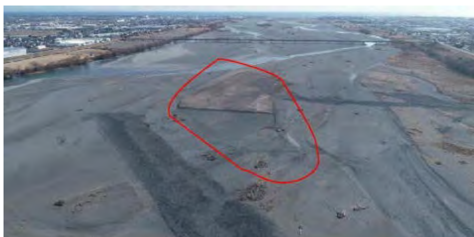
河道掘削施工前
