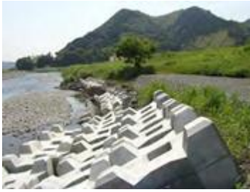
図 2-4 H18 被災応急復旧箇所
