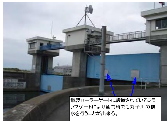
図 2-10 施設全景を下流より望む
