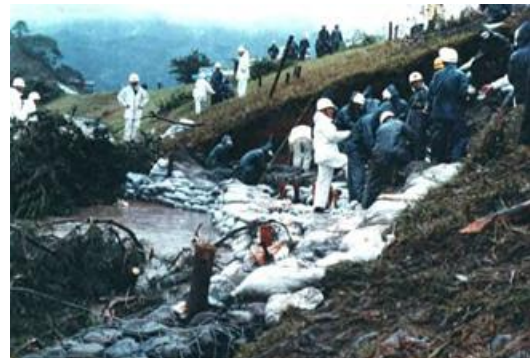
図 2-3 堤防洗掘応急復旧状況
