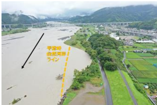
図 2-2 河岸侵食状況
