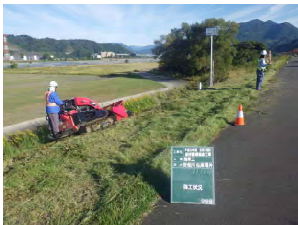
図－7 除草実施状況
