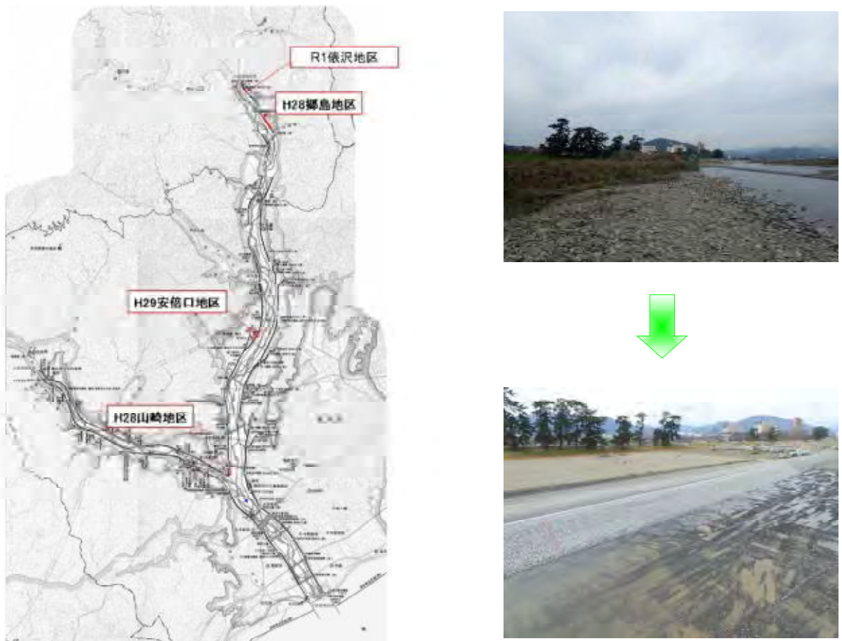
图-28 高水敷整備施工状况
