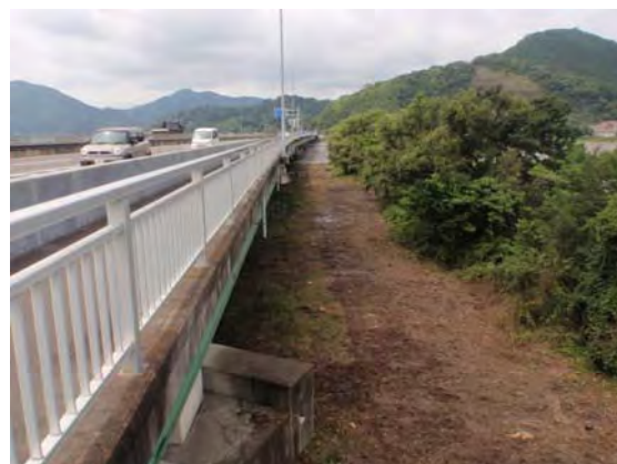
図-14 左記処理後の状況
