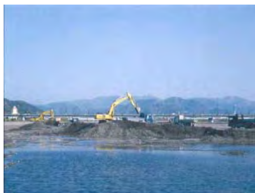
河道掘削状況
