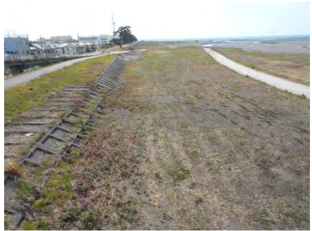
図-16 左記処理後の状況
