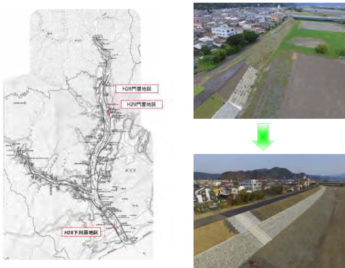
図-26 堤防強化対策施工状況
