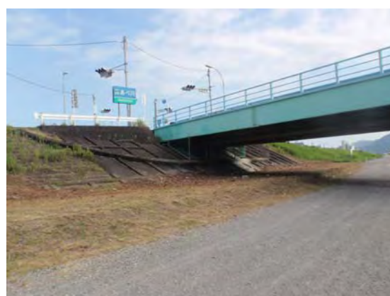
図-12 左記処理後の状況
