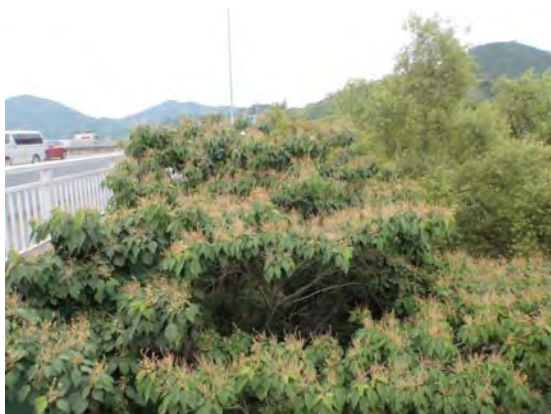
図-13 河川利用に支障となる倒木
