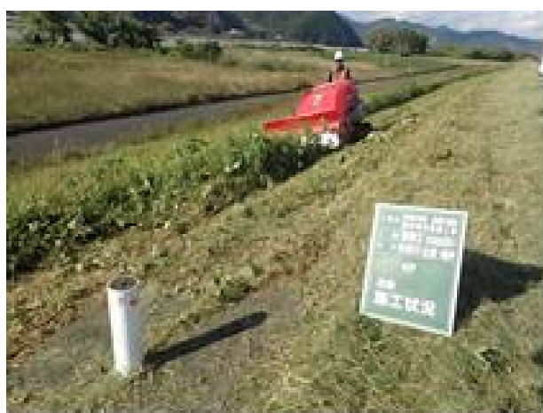
図－7 除草実施状況
