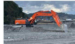
河道掘削状況
