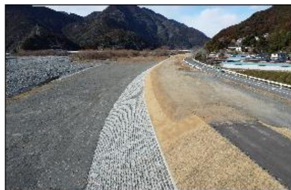
図-26 堤防強化対策施工状況
