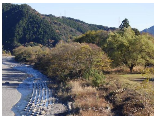
図－11 河川管理に支障となる雑木
