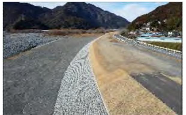
図-22 堤防強化対策施工状況
