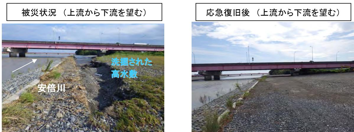
図-6 令和6年8月出水による被災状況
