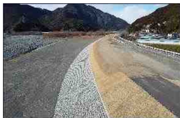
図-26 堤防強化対策施工状況
