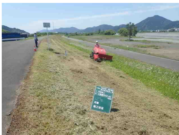
図－7 除草実施状況
