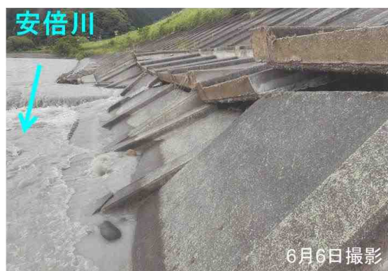
図-6 令和5年6月出水による被災状況
