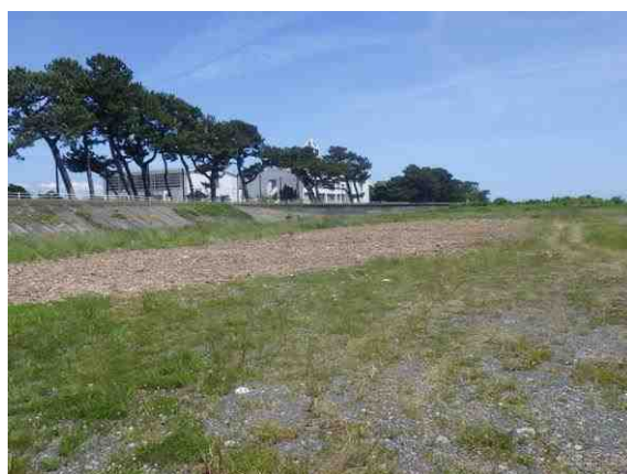
図-14 左記処理後の状況
