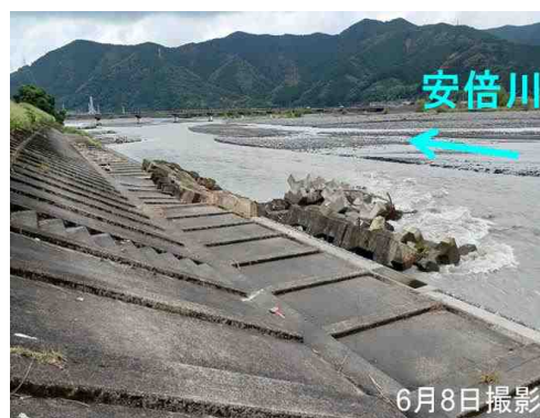
図-6 令和5年6月出水による被災状況
