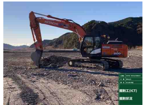
河道掘削状況
