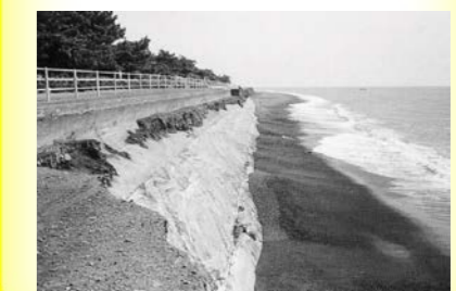
清水海岸の被災状況(H4)
