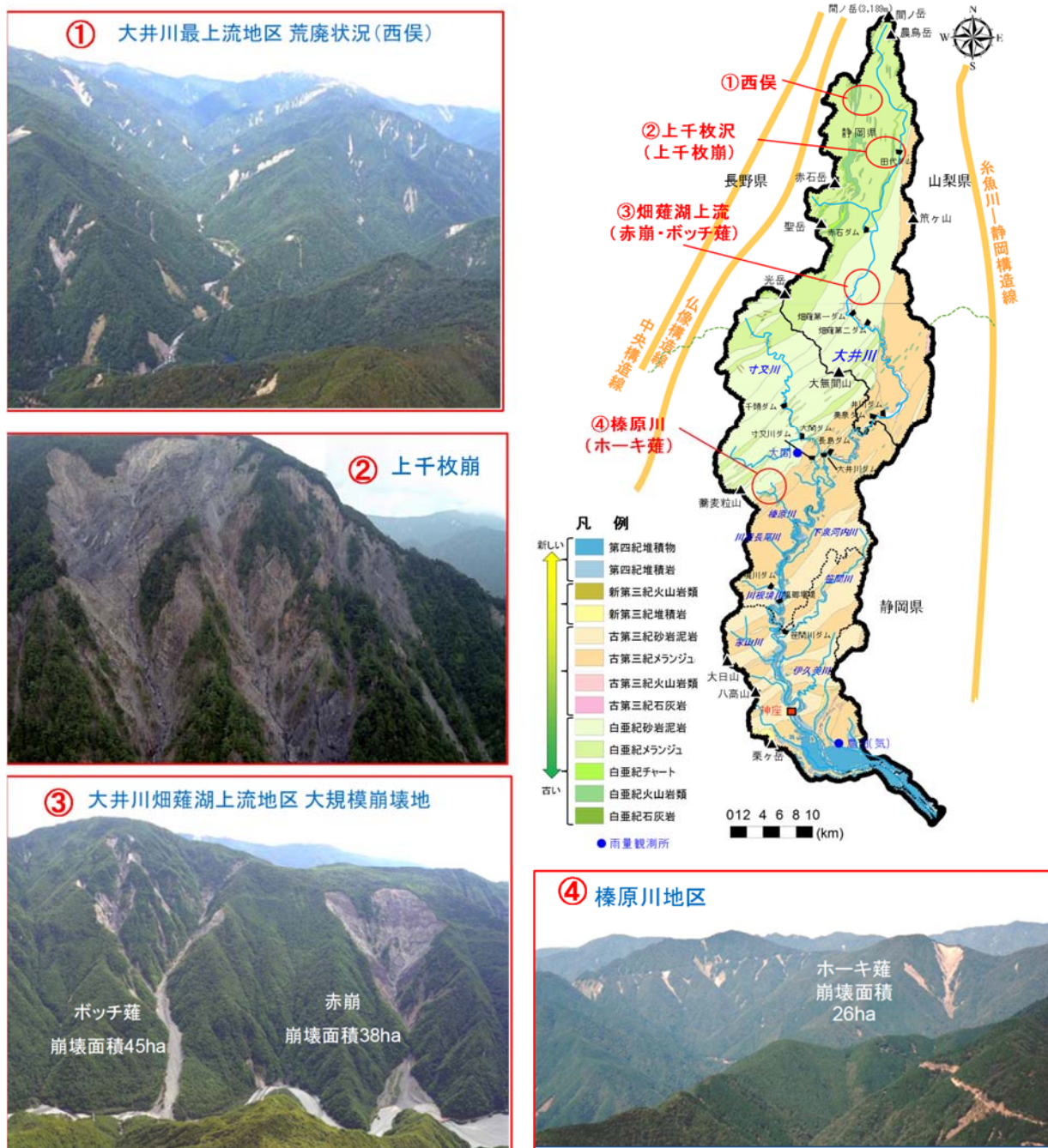
写真 3-1 流域の大規模崩壊地の例
