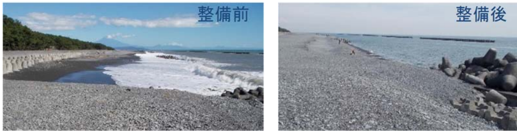
写真 3-9 養浜の実施状況（大井川工区）
