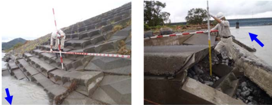
写真 3-6 河床低下による護岸等の崩壊（平成 23 年度被災；17.2km 付近左岸）
