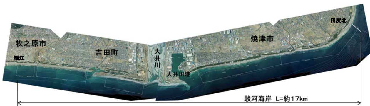
写真 2-2 駿河海岸の全景
