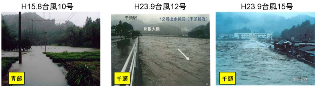
写真 3-5 過去の浸水被害の状況
