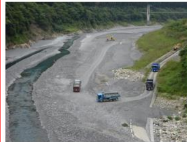
堆砂掘削工事の様子
