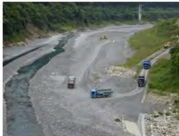
堆砂掘削工事の様子
