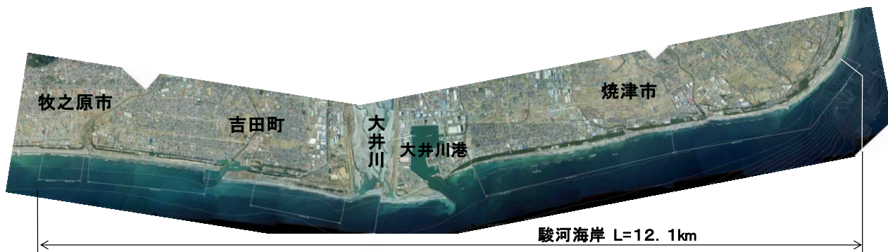
写真 2-2 駿河海岸の全景
