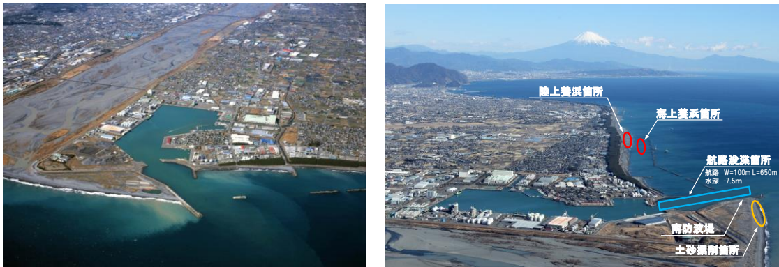
図 3-26 大井川港の全景（左）とサンドバイパスの実施箇所（右）
