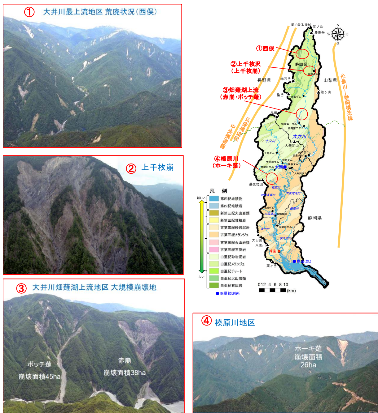
図 3-2 流域の大規模崩壊地の例
