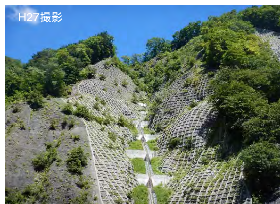
山腹工(②大井川 金沢)
