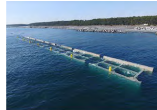
有脚式離岸堤
