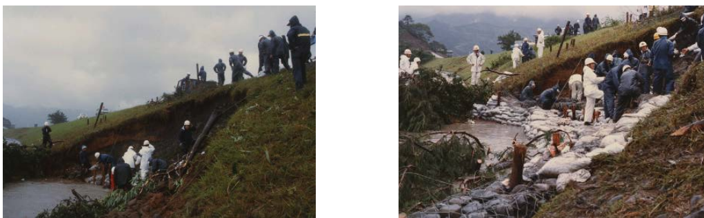
図 6-9 昭和 57 年 8 月洪水における堤防の被災状況（安倍川左岸 12.0k 付近）
