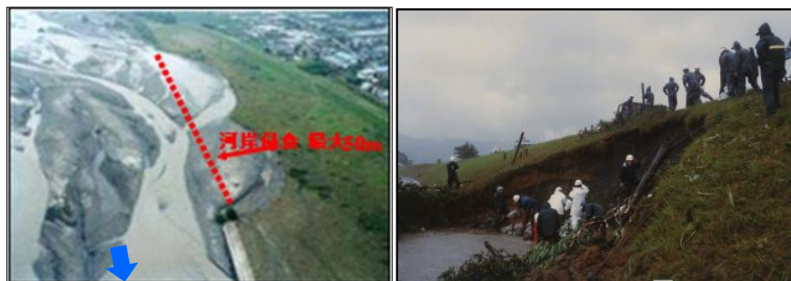
H12.9出水による被災状況(左岸11.75k) S57.8出水による被災状況(左岸12k)
