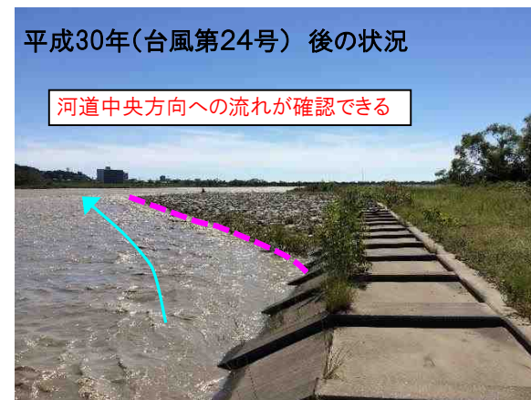
河岸防護対策(巨石付き盛土砂州)
