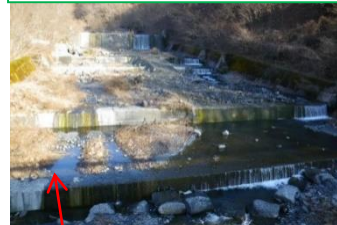
H29大島流路工改良工事
