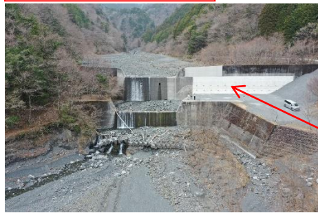
R4西日影川堰堤改良
