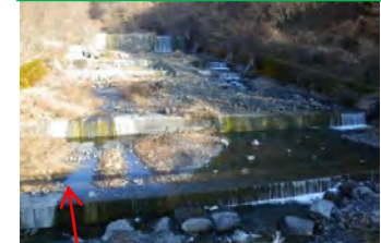
H29大島流路工改良工事
