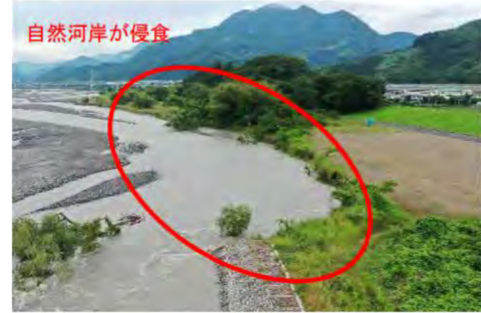
令和3年7月豪雨での被災状況(左岸12.0k)
