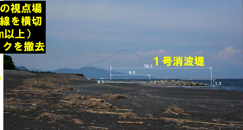
1号消波堤（ブロック撤去後）
