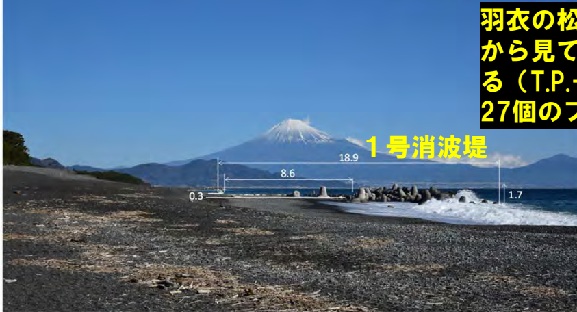
1号消波堤（ブロック撤去前）
